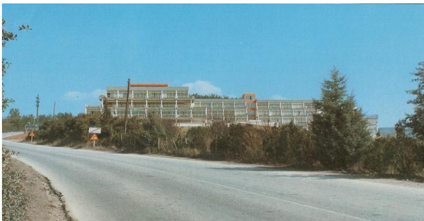
Εικόνα 1: Άποψη του σχολείου από το δρόμο του Πανοράματος
